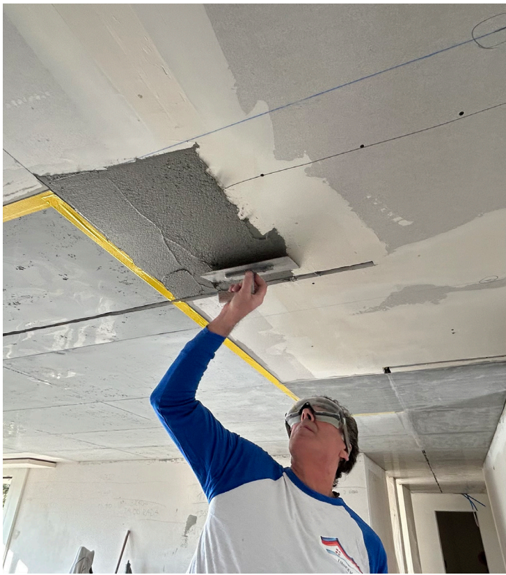
Die Sichtbetonoptik wurde mit SikaWall®-550 Magic aufgebaut und mit von SikaWall®-550 Foil strukturiert.
