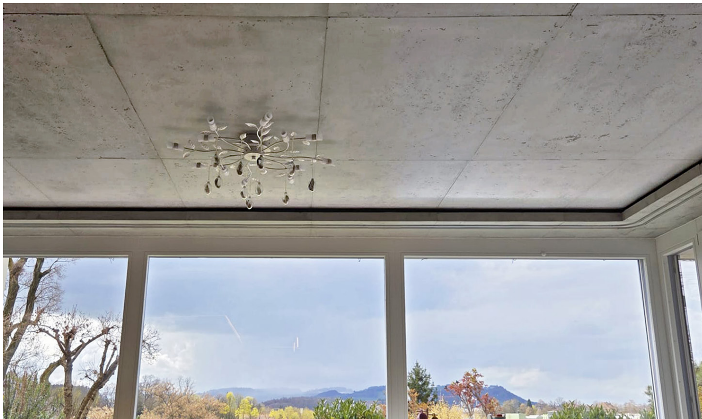
Moderne Deckenlösung: Auf Gipskarton wurde eine authentische Sichtbetonoptik gestaltet – mit gleichmässigem Erscheinungsbild, exakter Feldeinteilung und realistischem Fugenbild.
