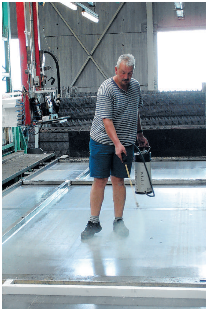
Ein Antihafmittel für die Schalung wird aufgesprüht.
