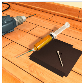
3. Applicare l'ago di iniezione (le cavità più grandi possono essere iniettate anche senza ago)
