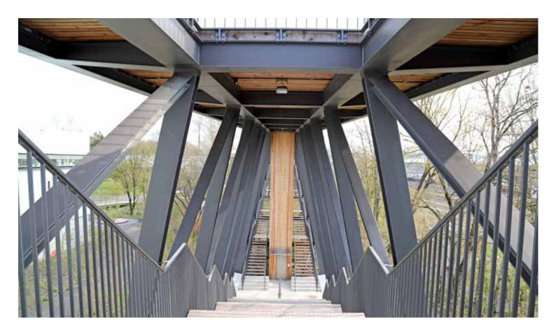
hend aus Grundierung, Zwischenbeschichtung und Decklack, hat das gesamte System eine Trockenschichtdichte von insgesamt nur 240 µm, also knapp einen Viertel Millimeter. Diese feine Schicht sorgt nicht nur für einen langlebigen Schutz, sondern rundet die Optik des Stahlfachwerks mit einem mattdunklen Grauton ab, der einen wunderschönen Kontrast zu den Holzdielen bildet.
