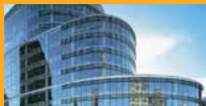
IMPERMEABILIZZARE E INCOLLARE
