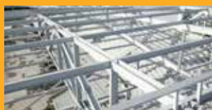
PROTEZIONE ANTINCENDIO E ANTICORROSIONE
