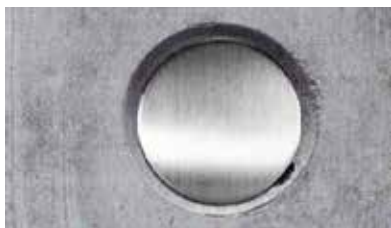
Abb. 9: Verschluss eines Bindlochs mit einem Edelstahlkonus
