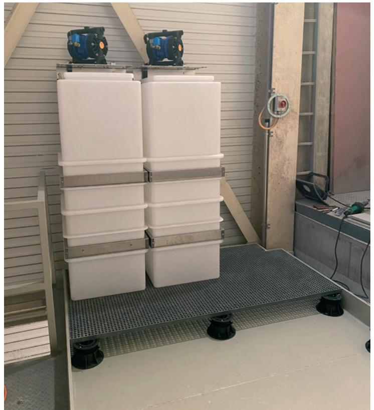
A Castione inoltre è stata eseguita una vasca impermeabile di sicurezza su sottofondo in calcestruzzo.
