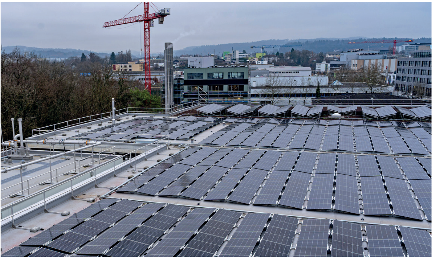
Für die grosse Dachfläche setzte die Greenpower Aarau AG auf ein Sika-Dachsystem – eine flammenfrei verlegte Lösung, ideal für Holzkonstruktionen und die Integration einer Photovoltaikanlage.
