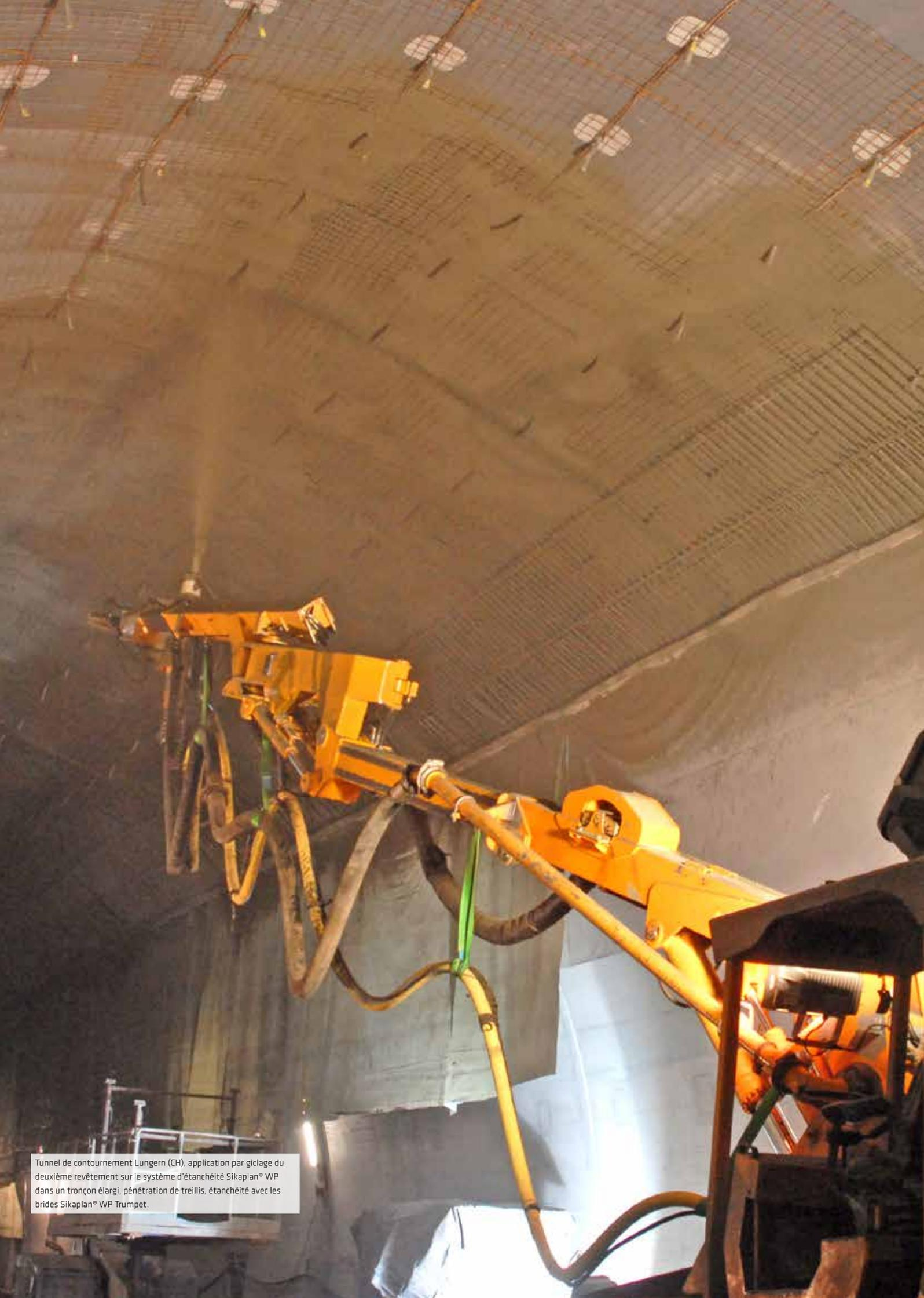
Tunnel de contournement Lungern (CH), application par giclage du deuxième revêtement sur le système d'étanchéité Sikaplan® WP dans un tronçon élargi, pénétration de treillis, étanchéité avec les brides Sikaplan® WP Trumpet.
