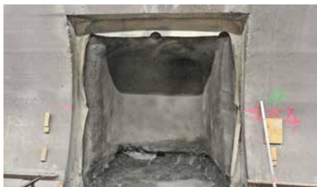
L'excavation d'une niche durant les travaux d'entretien permet d'accéder aux membranes d'étanchéité synthétiques Sika vieilles de 44 ans.
