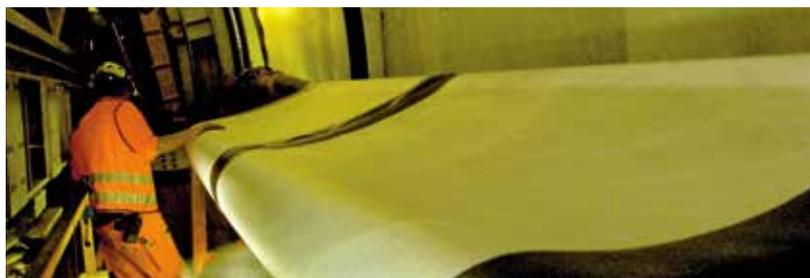
**LES MEMBRANES D'ÉTANCHÉITÉ SYNTHÉTIQUE DOUBLÉES DE FEUTRE** peuvent être collées par bande de façon entièrement automatique au moyen des systèmes de collage thermofusible sur des supports plans comme par exemple les voussoirs.
