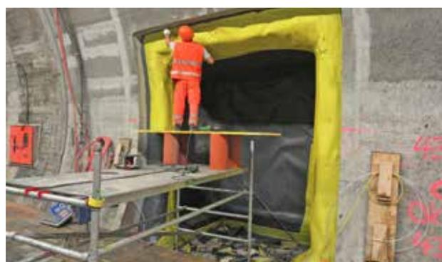
Travaux de raccordement d'une nouvelle membrane d'étanchéité synthétique sur une membrane posée il y a déjà plus de 40 ans. Les deux membranes d'étanchéité peuvent être soudées thermiquement.
