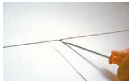
Tous les cordons de soudure manuels doivent être testés mécaniquement après le refroidissement complet. À cet effet, il faut utiliser un tournevis (largeur env. 5 mm, avec des angles obtus). Il faut exercer une légère pression sur le cordon de soudure. Éviter les griffures sur la membrane d'étanchéité synthétique. Le test mécanique permet de repérer les zones de soudure non complètes qui doivent être retouchées ultérieurement.
