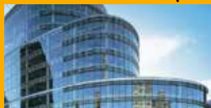
IMPERMEABILIZZARE E INCOLLARE
