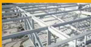
PROTEZIONE ANTINCENDIO E ANTICORROSIONE
