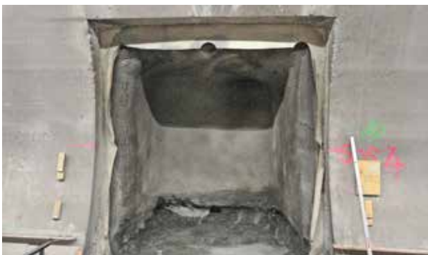
Una nicchia scavata durante i lavori di manutenzione consente l'accesso al telo sintetico d'impermeabilizzazione Sika posato 44 anni prima.
