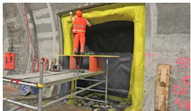
Lavori di collegamento di un nuovo telo sintetico d'impermeabilizzazione a una membrana posata da oltre 40 anni. I due teli d'impermeabilizzazione possono essere collegati mediante saldatura termica.
