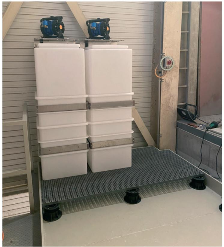
Die Auffangwanne unter den Tanks wurde vor Ort nach Mass angefertigt, geschweisst und eingebaut.
