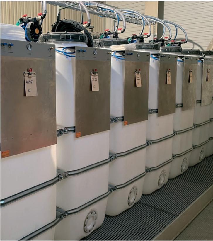
Die Frontbedienung der Membranpumpen ist dank verändertem Design nun auf Augenhöhe montiert.
