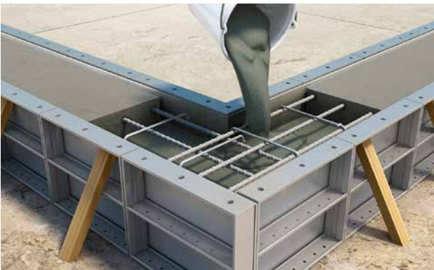
Ausgiessen von Brüstungen
