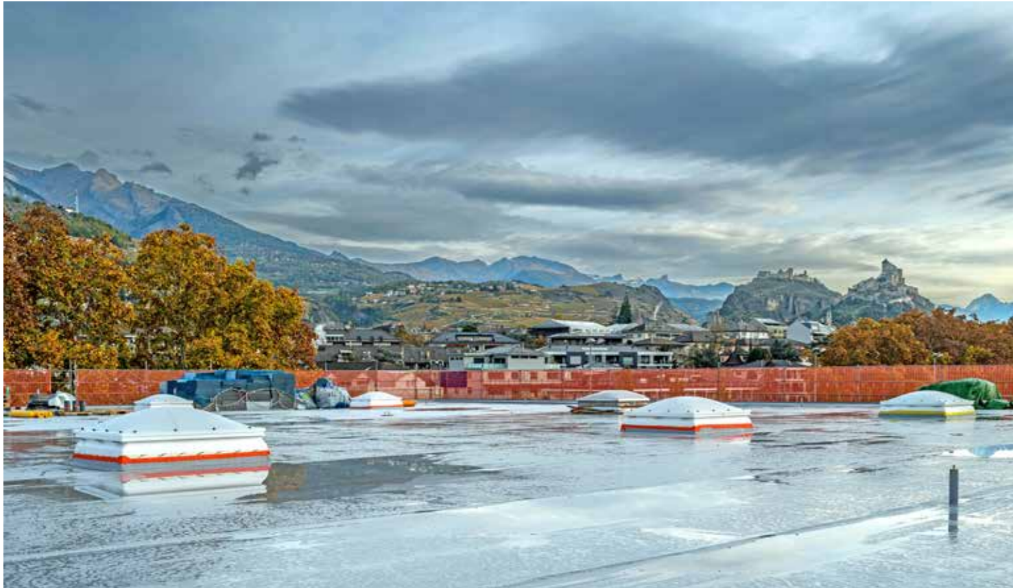
Le système de toiture Sika Hybrid-FPO est constitué de membranes d'étanchéité en plastique étanches à l'eau à base de polyoléfines thermoplastiques flexibles (Hybrid-FPO). Étant donné que le film a été traité sans flamme nue, le risque d'incendie n'était pas un problème.
