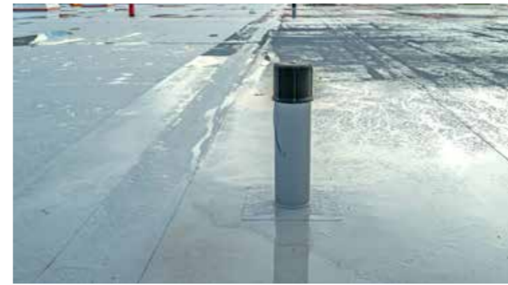
En complément du toit Sika, le système de surveillance SikaRoof® SmartControl permet une maintenance rapide et économique. Les dommages tels que l'infiltration d'eau sont détectés activement à un stade précoce.
