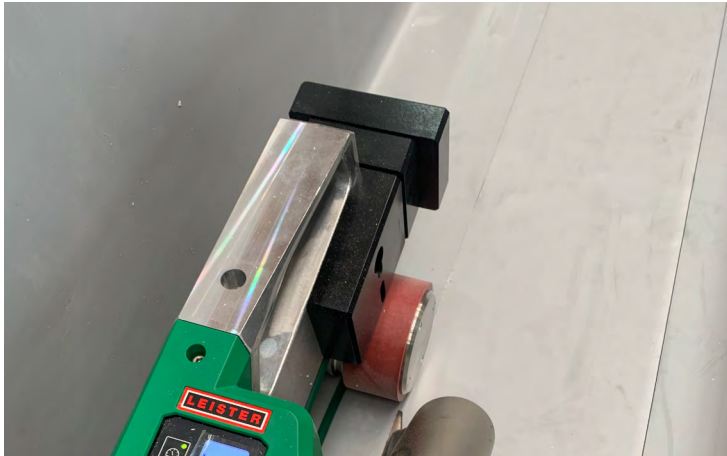
Verschweissung der Abdichtung mit Heissluft
