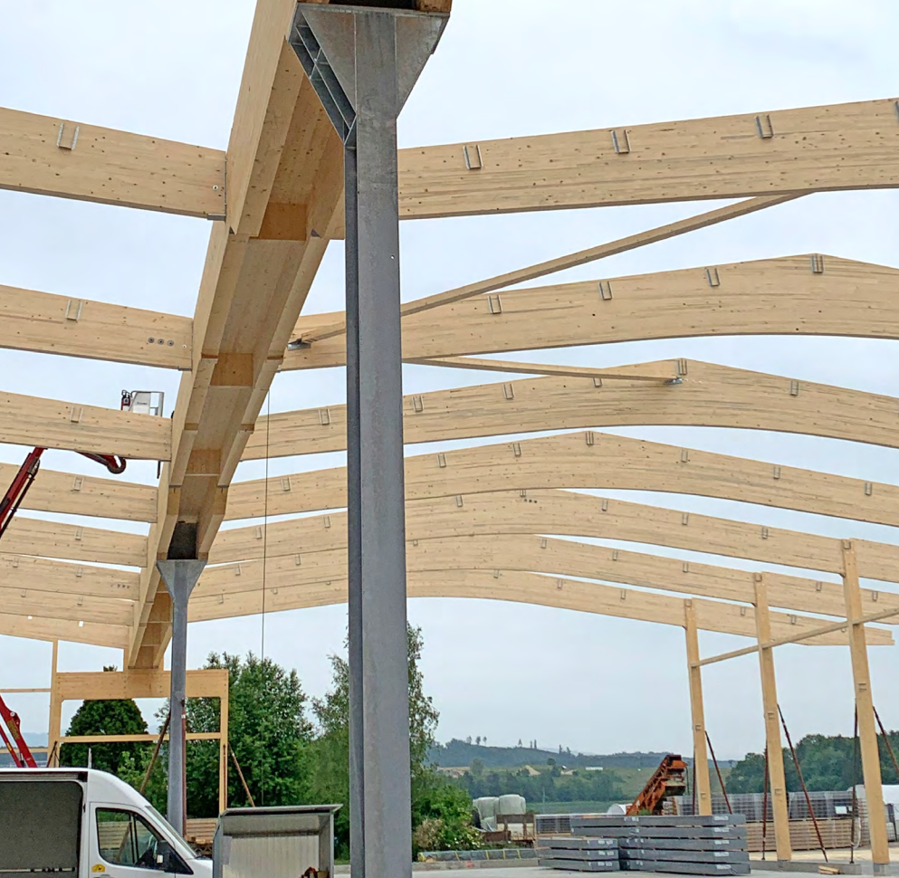
Zusammenschluss der Elemente auf dem Bau
