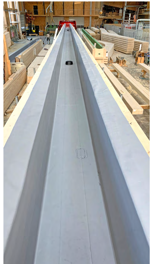
Fertig ausgekleidete Rinne in der Halle
