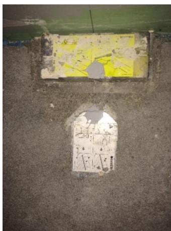
Abb. 2: Schutzfolie auf Chromstahlabdeckung (weiss) zwingend nach dem Einbringen des Estrichs entfernen
