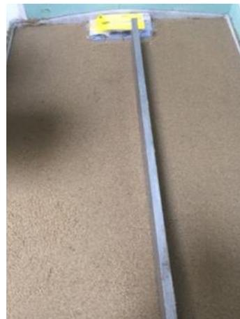
Abb. 4: Epoxidharz-Estrich mit Geberit Clean-Line (in der Mitte mit Messlatte)
