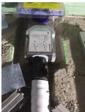
Abb. 1: Geberit CleanLine mit Grundkörper und Anschlussleitung
