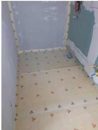
Abb. 5: Alternativ zu Schönox® 1K DS Premium mit SikaCeram® Sealing Membrane W oder SikaCeram® Sealing Membrane A
