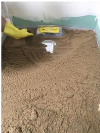
Abb. 3: Einbau des Epoxidharz-Estrich mit Geberit CleanLine
