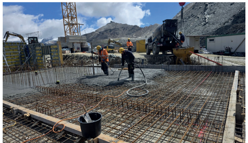
Betonage Bodenplatte Garagierung.
