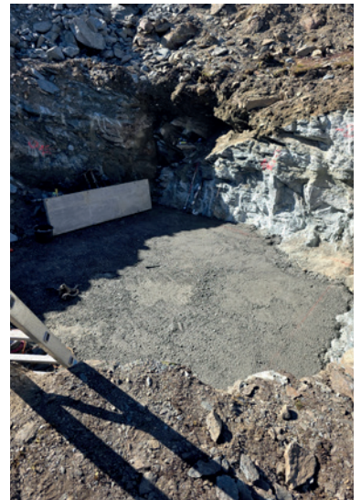
Sauberkeitsschicht Mastfundament
