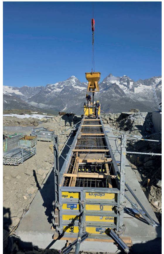
Betonarbeiten am Fundament der Bergstation.
