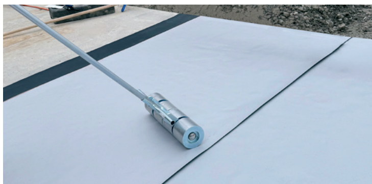
Étape de traitement 3: presser avec un rouleau
