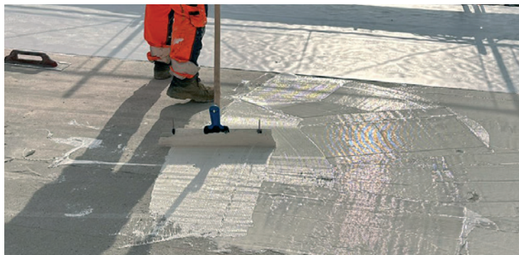
Étape de traitement 1: application de la colle
