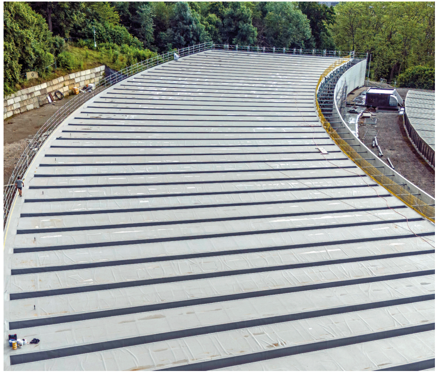
Für die Flachdachflächen kam die Kunststoffdichtungsbahn Sarnafil® TS 77-18 zum Einsatz.
