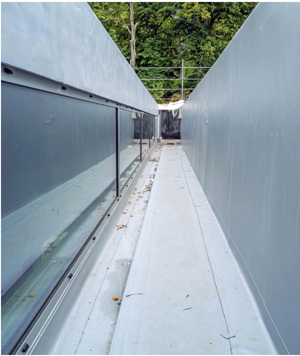
Das Gebäude wird von Spannbetontträgern geprägt, die grosse Spannweiten ermöglichen.
