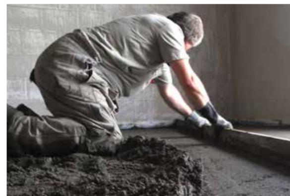
beheizt werden. Das “Begleitheizen” in Kombination mit optimalen Baustellenbedingungen lässt eine Belegereife von 7 bis 28 Tagen nach Einbau zu. Das Heizprotokoll muss eingehalten werden, wenn eine maximale Reduktion der Austrocknungszeit auf wenige Tage oder Wochen gefordert wird.
