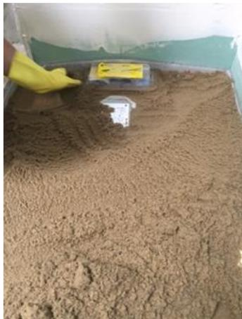
Fig. 3: pose de la chape en résine époxy avec Geberit CleanLine
