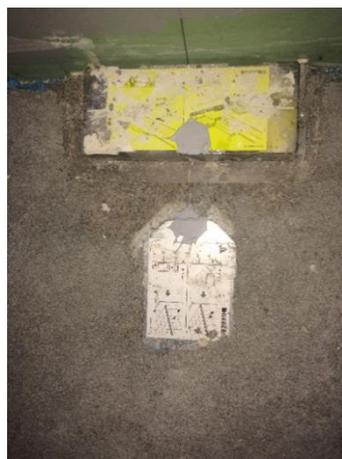
Fig. 2: retirer impérativement le film de protection sur le recouvrement en acier chromé (blanc) après la pose de la chape
