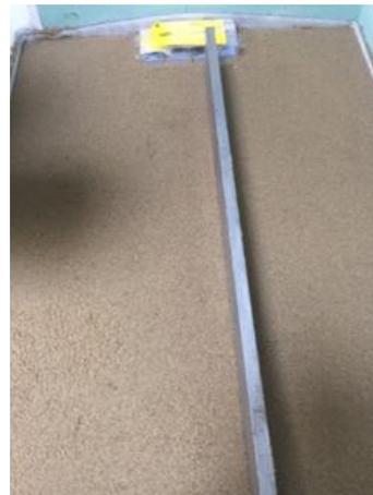
Fig. 4: chape en résine époxy avec Geberit Clean-Line (au milieu avec la règle)
