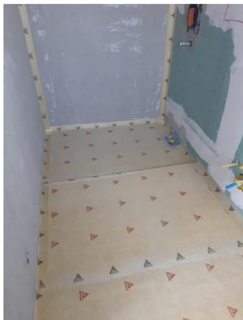
Fig. 5: solution alternative à Schönox® 1K DS Premium avec SikaCeram® Sealing Membrane W ou SikaCeram® Sealing Membrane A
