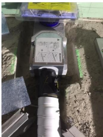
Fig. 1: Geberit CleanLine avec corps de base et conduite de raccordement
