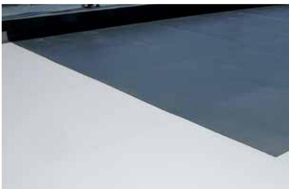
Strato di protezione in materiale riciclato che protegge l'impermeabilizzazione da danneggiamenti meccanici
