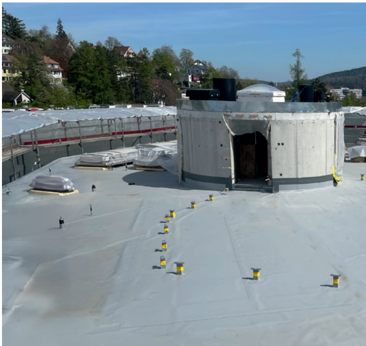
Die Abdichtungsbahn Sarnafil® TG 66-18 wird mit Heissluft, also komplett ohne Flammen, verschweisst.
