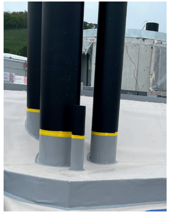
Der Dachaufbau des SWICA Neubaus hat einen sehr individuellen Charakter.
