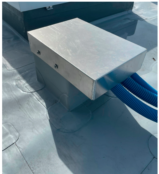
Die Verleger brauchten neben Erfahrung auch ein sehr gutes Geschick im Umgang mit individuell angepassten Kunststoffabdichtungsbahnen..
