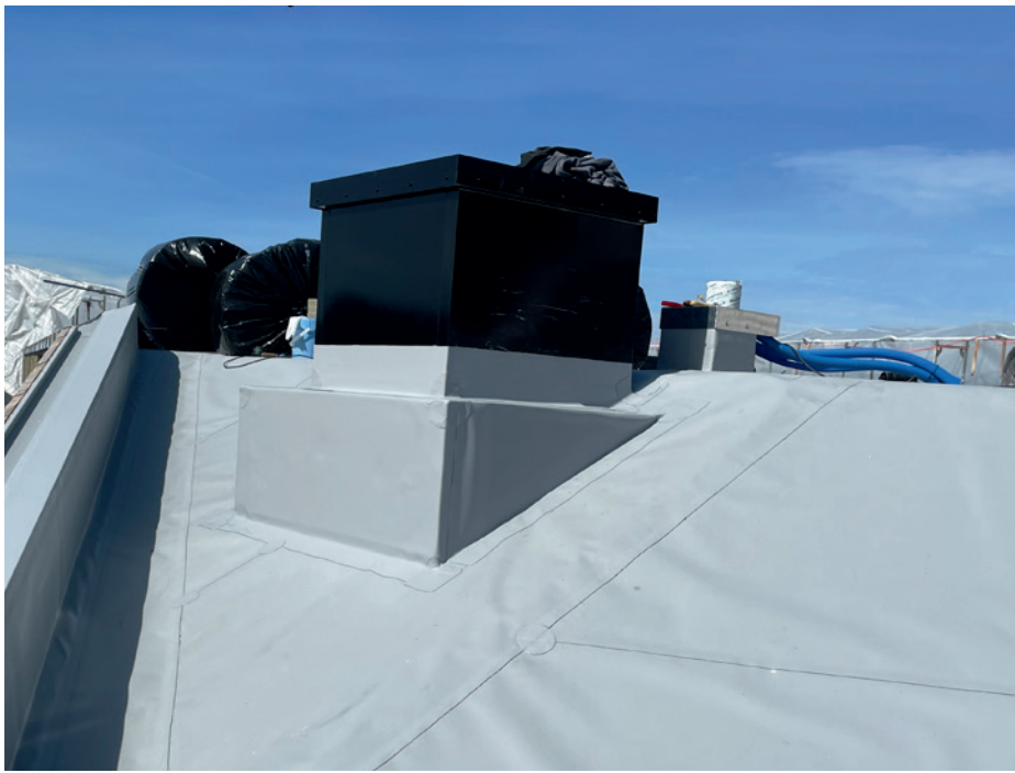
Die Bauherrschaft entschied sich für ein Sika Dachsystem wegen der einfachen Ausführung von komplexen Geometrien.
