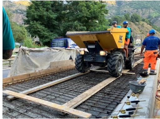
Abb. Nr. 16: Transport zur Einbaustelle mittels Dumper
