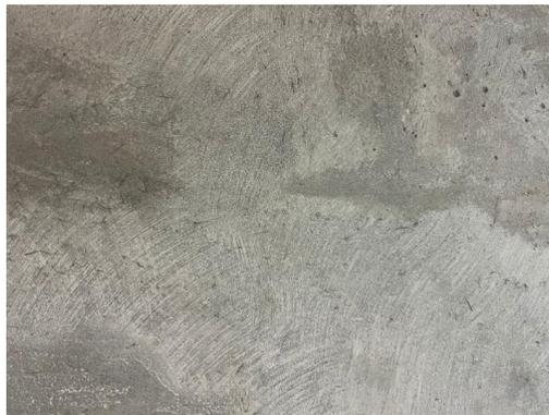
Abb. Nr. 38, 39: Kugelstrahlen einer UHFB-Oberfläche
