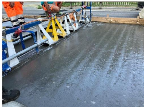
Abb. Nr. 23, 24: Belagsfertigung mittel Rüttelbohlen
