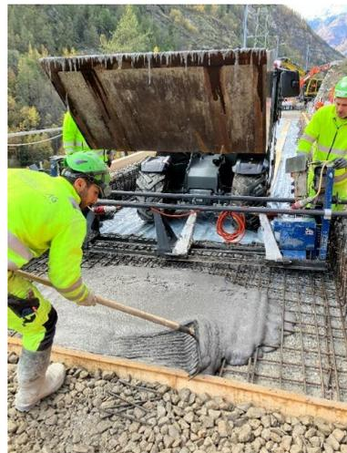
Abb. Nr. 19-22: UHFB-Einbau und Verteilung mittels Schaufeln und Betonrächen
