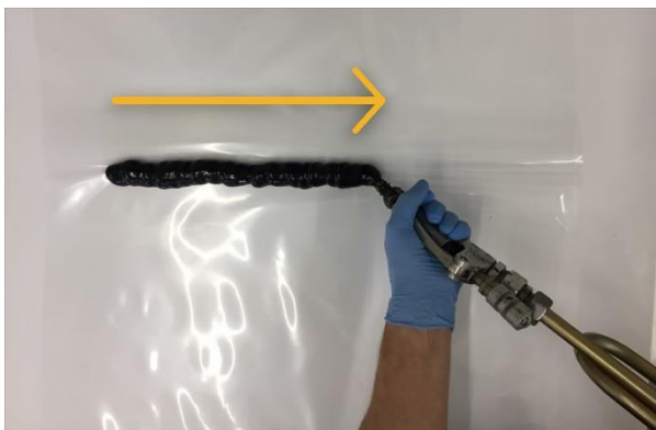
FIGURE 9 Appliquer un cordon de colle le long du pli
