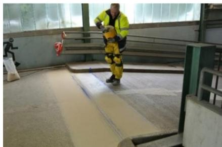
Prima di rivestire il profilo per giunti, proteggere l'inserito di gomma con del nastro adesivo. Dopo di che, applicare la mano di fondo e cospargere a rifuso con sabbia di quarzo.
