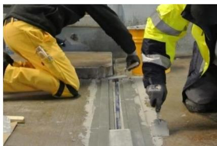
Utilizzando l'adesivo di sistema Sikadur® colmare con una spatola la fessura rimanente tra superficie in calcestruzzo e profili, così da chiudere ogni cavità.
