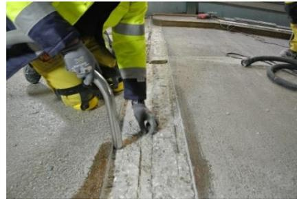
Una volta realizzato l'alloggiamento, il substrato va smerigliato a diamante.
