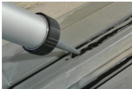
Applicare l'adesivo EPDM SikaBond®-444 Membrane Fix sia nelle due piccole scanalature a destra e a sinistra, sia sul lato superiore dell'incavo.
