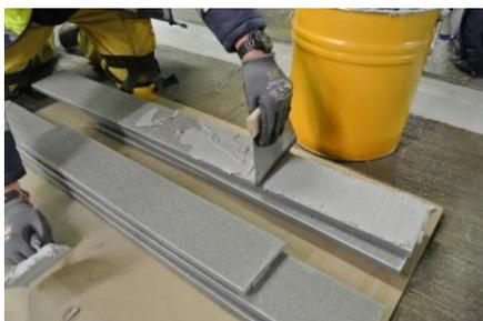
Applicare uno strato di adesivo anche sulla parte posteriore dei profili utilizzando un frattazzo con denti a V.
