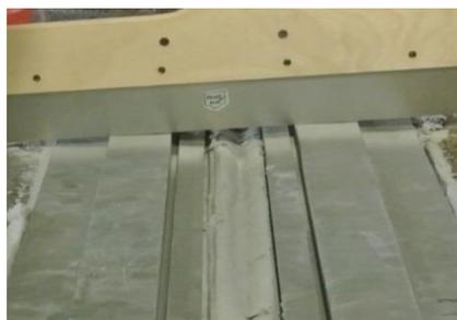
Per la regolazione laterale dei profili lo strumento più adatto è una spatola liscia o una livella a bolla.
