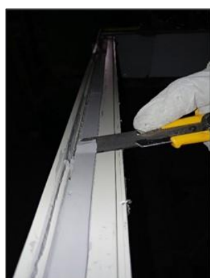
Abbildung 37: Prüfen der Haftung entlang des gesamten Rahmens – Gutes Haftergebnis
