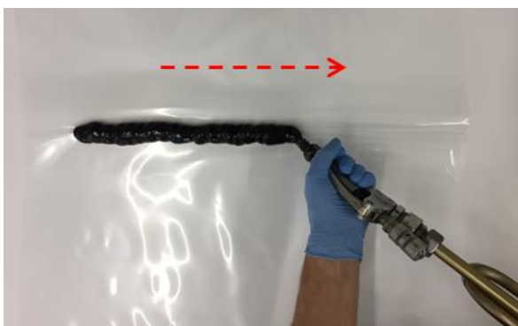
Abbildung 5: Klebstoffraupe auf dem Falz aufbringen
