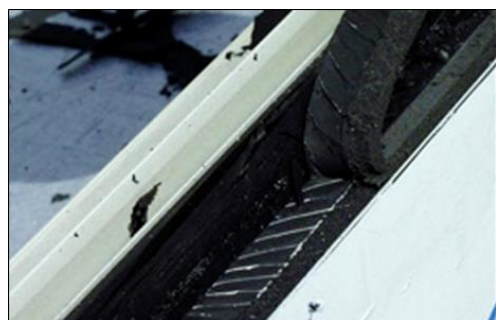
Abbildung 39: Beispiel mit schwarzer SG-Fuge gutes Haftergebnis
