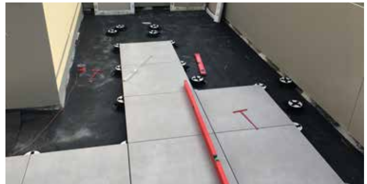
Mit dem Brandschutzvlies NonFlame T10 wurden auf den Terrassen die Brandschutzvorschriften für offene Platten vollumfänglich erfüllt.
