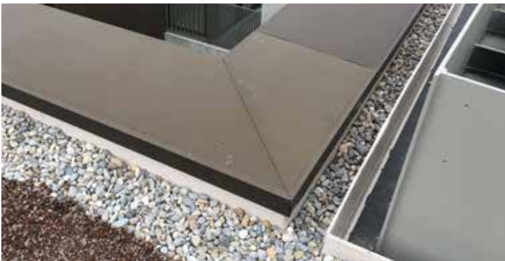
Auch schlanke Trennkonstruktionen (schmäler Übergang Attika - begrüntes Dach) können mit einem Sika-Dachsystem einfach, sicher und kostengünstig ausgeführt werden.
