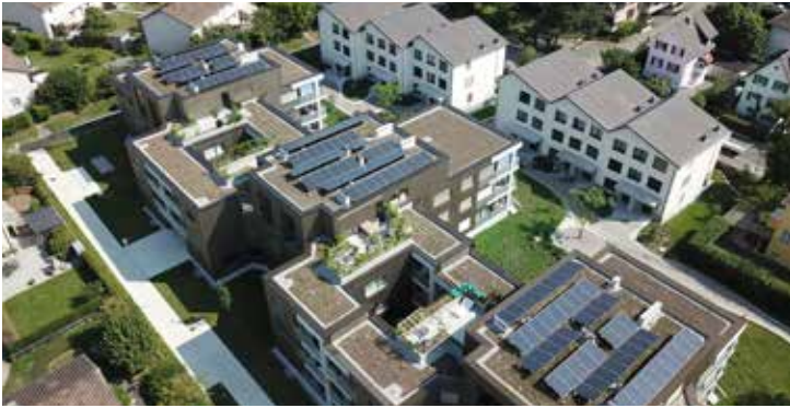
Die verschiedenen Arten von Dächern mussten sorgfältig geplant und alle Details normgerecht gelöst werden.
