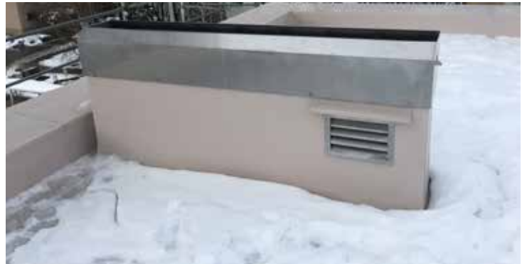
Trotz Wintereinbruch konnten die Abdichtungsarbeiten mit den TPO-Kunststoffdichtungsbahnen ohne Unterbruch fortgesetzt werden.
