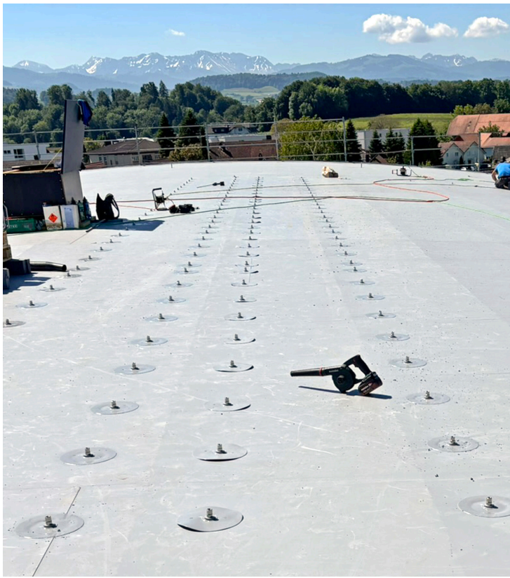
Das SikaRoof® Anchor System schafft statisch belastbare Befestigungspunkte auf der Dachoberfläche.
