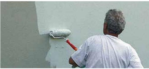
Abb. 8.8.2: Da die Beständigkeit von Beton gegen chemische Angriffe begrenzt ist, werden häufig Schutzbeschichtungen für den Aussenschutz verwendet.
