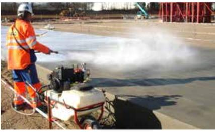
Abb. 8.10.2: Die sofortige Abdeckung oder Nachbehandlung von Betonoberflächen, die der Witterung ausgesetzt sind, ist der wichtigste Schritt zum Schutz solcher Oberflächen und zur Reduzierung vom plastischem Schwinden.
