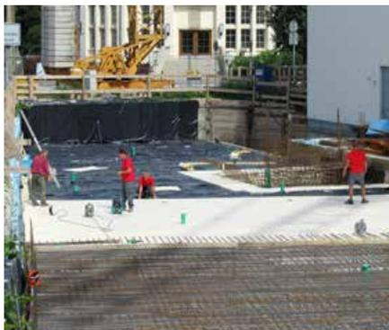
Es ist bekannt, dass Beton durch eine sorgfältige Rezeptur und die Verwendung von Zusatzmitteln so gestaltet werden kann, dass er undurchlässig für drückendes Wasser ist. Um ein Betonbauwerk vollständig wasserdicht zu halten, muss mehr als nur die Betonrezeptur berücksichtigt werden. Weltweit gibt es viele Ausdrücke, die einen "wasserdichten Beton" beschreiben. Im Allgemeinen kann man zwischen "wasserdichtem Beton", "wasserdichten Betonsystemen" und der "Weissen Wanne" unterscheiden.
