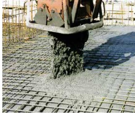
Die Vielseitigkeit dieser Anwendungsmethode und die Tatsache, dass keine spezielle Betonrezeptur erforderlich ist, sind die grössten Vorteile. Dadurch sind Kranbetonanwendungen äusserst wirtschaftlich. Zudem ist es eine sehr einfache Einbauart, denn sobald ein Kran auf der Baustelle vorhanden ist, kann der Unternehmer jede Art von Beton mit dem Kübel einbringen. Fast jede Art von Beton lässt sich auf diese Weise einbringen, wie zum Beispiel:
