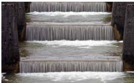
Abb. 8.71: Gerade im Wildwasser sind Betonoberflächen massiven Zusatzbelastungen durch Geröll, scharfe Kanten und Abrieb sowie möglichen Temperaturbelastungen durch Frosteinwirkung ausgesetzt.
