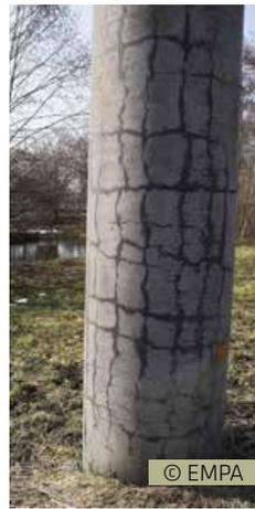
Abb. 8.6.3: An der trocknenden Betonoberfläche dieses Brückenpylons lässt sich das Erscheinungsbild der AAR-Schäden sehr gut beurteilen. Die Schäden können innerhalb von Jahren oder erst nach Jahrzehnten auftreten.
