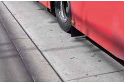
Abb. 8.7.2: Fahrbahnen aus Beton und andere öffentlich zugängliche Flächen, insbesondere solche mit hohem Verkehrsaufkommen oder konzentrierter Belastung, sind hohen mechanischen Belastungen und starkem Abrieb ausgesetzt, was oft zu einer glatten, rutschigen Oberfläche führt.
