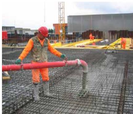
Selbstverdichtender Beton (SVB / SCC) hat aufgrund eines höheren Bindemittelgehalts und einer anderen Siebkurve einen höheren Mehlkornanteil als herkömmlicher Beton. Diese Anpassungen in Kombination mit speziell angepassten Fließmitteln sorgen für ein einzigartiges Fließvermögen und Eigenverdichtverhalten.
