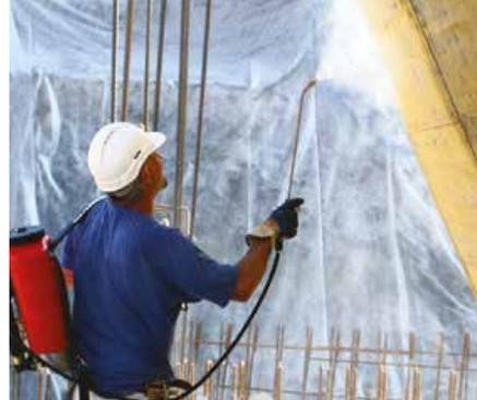
Dies kann durch die richtige Anwendung eines geeigneten Schalungstrennmittels erreicht werden, was zusätzlich zu glatten und dichten Betonoberflächen führt, die sowohl die Dauerhaftigkeit als auch das ästhetische Erscheinungsbild der Betonoberfläche verbessern. Die folgenden Anforderungen gelten für die Wirkung von Schalungstrennmitteln, sowohl beim Einbringen von Ortbeton als auch für Betonfertigteilanwendungen:
