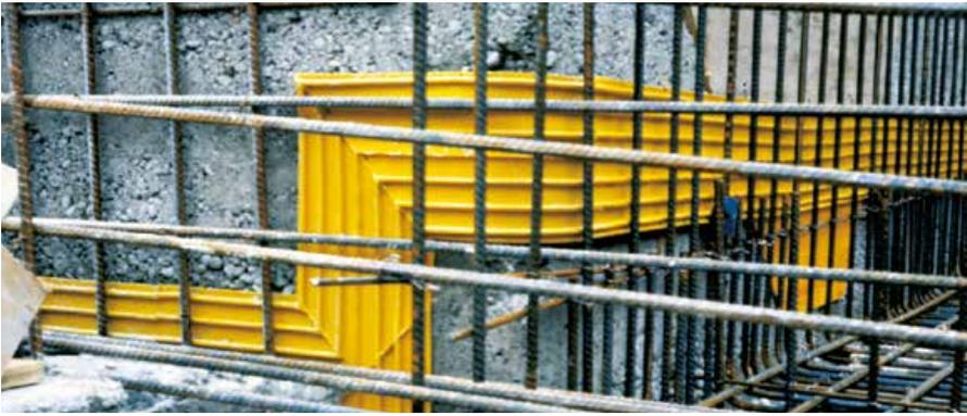
Abb. 8.1.2: Sika Fugenbänder sind elastische, vorgeformte PVC-Bänder für die Abdichtung von Bewegungs- und Arbeitsfugen, die niedrigem und hohem Wasserdruck ausgesetzt sein können.
