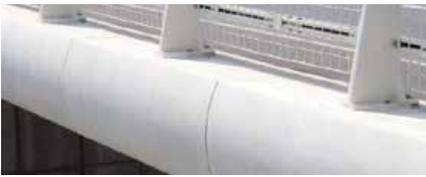
Abb. 8.9.4: Hoch beanspruchte Bauteile wie Stützen und Träger werden aus hochfestem Beton hergestellt. Die hohe Widerstandsfähigkeit gegen äussere Einflüsse macht hochfesten Beton auch zu einer idealen Schutzbeschichtung für exponierte Bauelemente.
