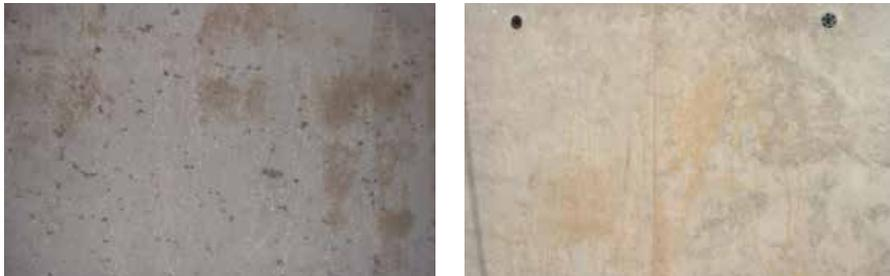
Abb. 10.1.2: Applikationsfehler: Schlecht gereinigte Schalung und überschüssiges Schalöl.
