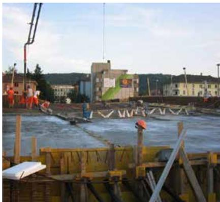
Je dünner der Trennmittelfilm ist, desto besser sieht die spätere Betonoberfläche aus. Es wurden lösungsmittelbasierte Schalungstrennmittel und wasserbasierte Emulsionen entwickelt, da diese Technologien eine schnelle und einfache Anwendung dünnster Trennmittelfilme ermöglichen.
