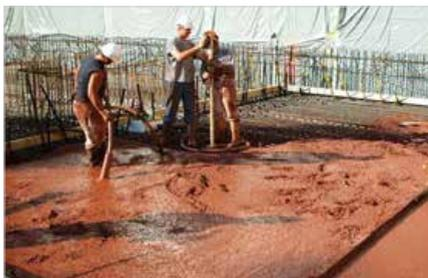
Abb. 8.16.1: Der Boden, die Wände und die Decke dieses Krankenhauses wurden aus Schwerbeton mit Hämatit-Metallzuschlägen hergestellt, um einen vollständigen und sicheren Strahlenschutz zu gewährleisten.
