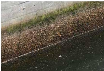
Abb. 8.8.1: Starke Auslaugungen und Schäden an der Betonstruktur werden insbesondere in der Spritzwasserzone von biologischen Behandlungsbecken beobachtet.
