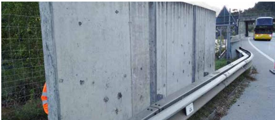
Abb. 8.2.4: Potenzialmessung an einer Stützmauer entlang einer stark befahrenen Strasse mit hohem Einsatz von Streusalz nach weniger als 10 Jahren Exposition. Je dunkler die Färbung, desto höher ist das Korrosionspotenzial.
