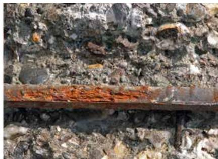
Abb. 8.2.1: Beschädigung der Betonstruktur durch unzureichende Betonüberdeckung und schlechte Betonqualität
