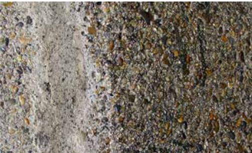
Abb. 8.7.4: Durch die ständige Einwirkung wird die Zementhaut in einem ersten Schritt abgetragen und anschliessend können die Gesteinskörnungen aus dem Zementleim herausgerieben, herausgeschlagen oder herausgewaschen werden.
