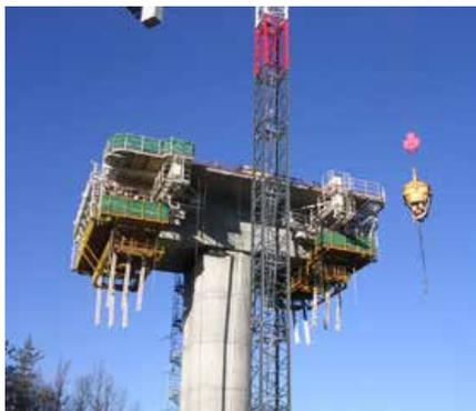
Die Kletterstangen befinden sich oben in Rohrhülsen und stützen sich auf dem bereits ausgehärteten Beton ab. Auch die Stangen und Hülsen werden kontinuierlich angehoben. Diese Arbeiten werden fast ausschliesslich von erfahrenen Spezialfirmen ausgeführt. Die Gleitschalungstechnologie ist schnell und effizient.
