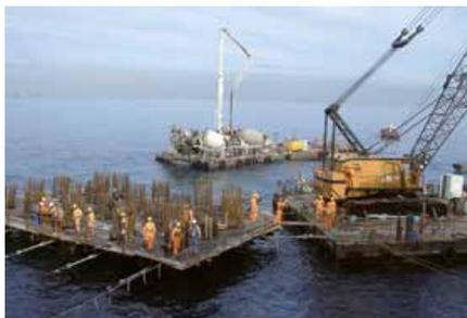
Abb. 8.14.1: Bei der Verwendung von Unterwasserbeton sind die Einbau- und Arbeitsbedingungen sehr oft komplex, weshalb diese Betone oft auch eine längere Verarbeitungszeit benötigen.
