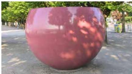
Abb. 8.12.1: Dank der Entwicklung von SCC (selbstverdichtendem Beton) sind die Möglichkeiten für Planung und Bau nahezu unbegrenzt und mit spezieller Schalungstechnik und / oder speziellen Betonzusatzmitteln lassen sich selbst in den schwierigsten Bereichen hochwertige Oberflächen erzielen.
