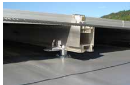
Die Solarpaneele wurden mittels Sol-F Befestigungen auf das Nacktdach montiert.
