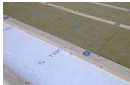
Auf die EPS-Dämmung wurden Holzeinlagen als Basis für die Befestigung der Solarpaneele gelegt.
