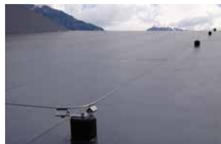
Für die Sicherheit auf dem Dach entschied man sich für das Seculine Vario Seilsystem.
