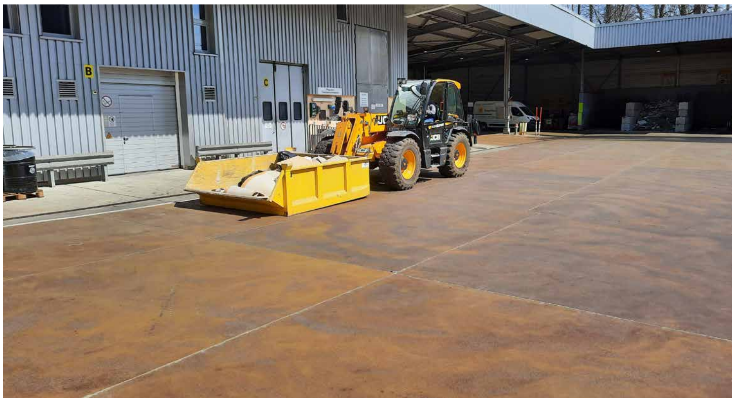
Impianto di smaltimento dei rifiuti urbani di Horgen
