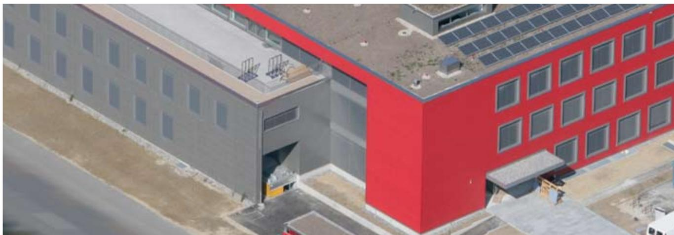
bildet den krönenden Abschluss des 1300 m<sup>2</sup> grossen Flachdaches. Damit sind Minergie, Sicherheit, Retention und Ästhetik in einem ökologischen System vereint.
