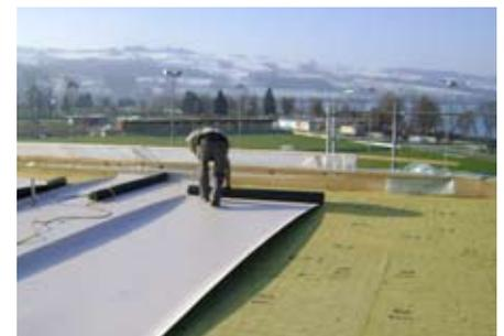
*Die mit Sarnafil T abgedichtete Dachfläche wurde begrünt und auf 145 m<sup>2</sup> eine Photovoltaik-Anlage mit einer Leistung von 19.98 kWp montiert.*
