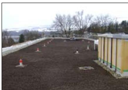
*Auch für die Sicherheit auf dem Dach wurde gesorgt: mit der Seculine Vario Absturzsicherung und Kontrollrohren.*
