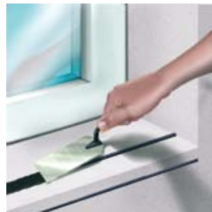
Verteilen der Klebstoffraupe
