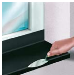
Folie in überschüssigen Klebstoff einbetten
