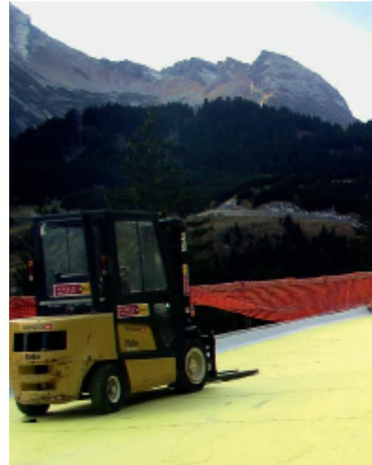
Lawingalerie mit vollflächig verklebten PVC Dichtungsbahnen.
