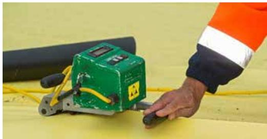
Soudage de membranes d'étanchéité en plastique
