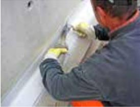
Si les bandes doivent être assemblées, cela doit s'effectuer en principe par soudage.
