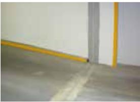
Pour les passages, le joint de dilatation peut être recouvert, côté intérieur, du système Sikadur-Combiflex® SG pour plus de sécurité.
