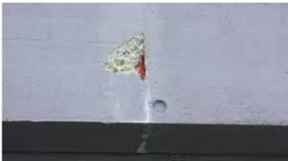
*Éclatement en raison d'un recouvrement insuffisant*
