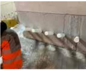
Le barrage horizontal est réalisé en maçonnerie avec le SikaMur® Injection-1. Il peut uniquement être réalisé en cas d'une faible accumulation d'eau, comme le montre l'image, mais en règle générale, une pression d'injection de 5 à 10 bar est nécessaire.
