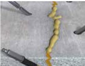
En règle générale, la disposition est effectuée à 45° en biais par rapport à la fissure en décalage (à droite et à gauche de la fissure) avec un écart correspondant à la moitié de l'épaisseur de l'élément de construction.
