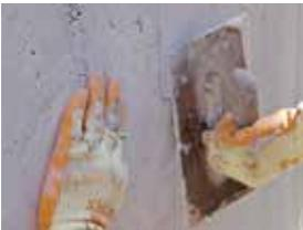
Une autre couche de colle est appliquée sur la bande posée. La colle peut alors être lissée ou sablée, en fonction de l'utilisation prévue ultérieurement.
