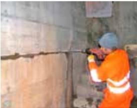
La fissure est percée pour laisser place à la garniture. Il est également possible d'utiliser des garnitures adhésives qui sont à coller directement sur la fissure.
