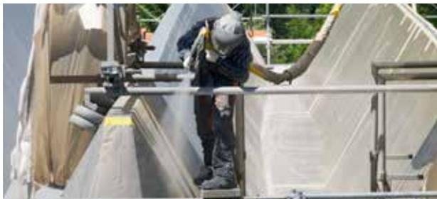
*Application de polyuréa hautement réactif*
