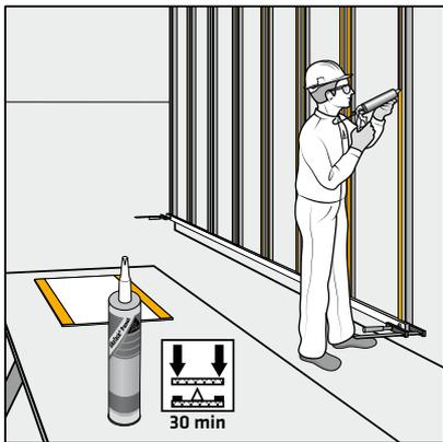
Applicazione di un cordone triangolare di adesivo SikaTack® Panel tramite l'apposito ugello fornito con il prodotto (larghezza 8 mm, altezza 10 mm). distanza di almeno 5 mm dal nastro di montaggio.
