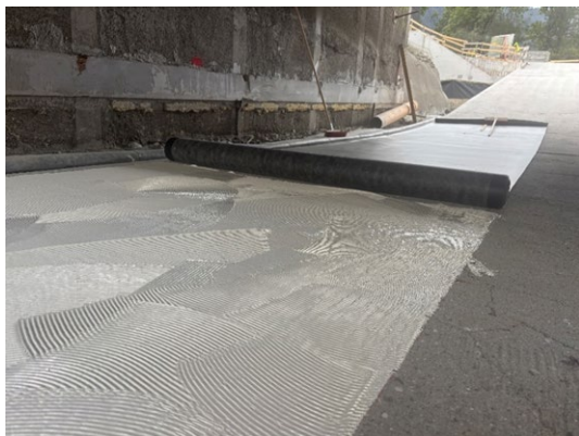
Abb. 6: Einlegen der SikaRoof® AT
