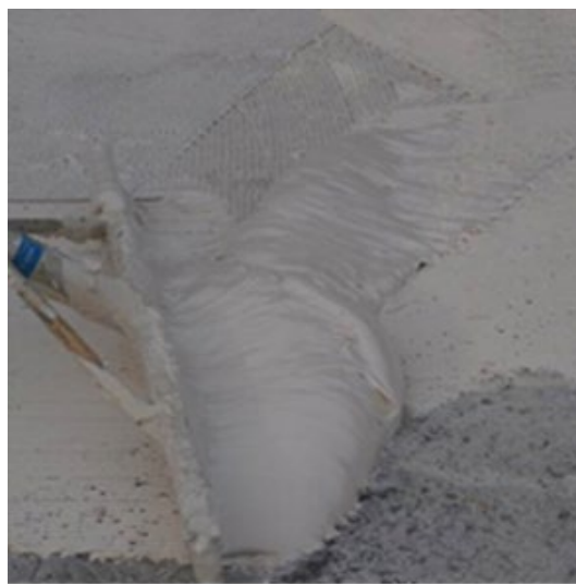
Abb. 5: Aufbringen des Klebstoffs mit einer Zahnrakel
