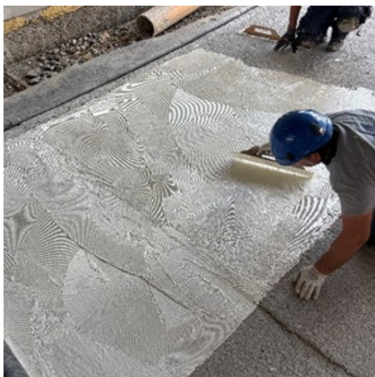
Abb. 4: Aufbringen des Klebstoffs mit einer Zahntraufel
