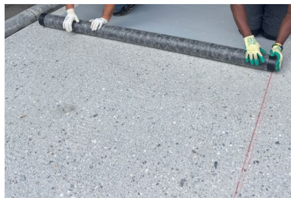
Abb. 2: Aufrollen der Bahnen nach Einzeichnung des Klebebereich
