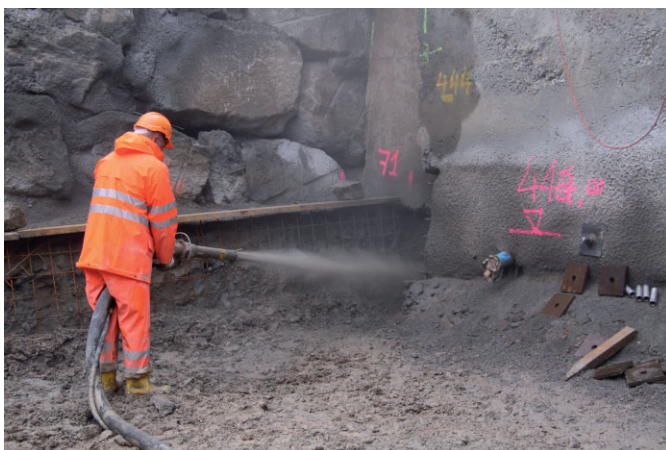
Fig. 2. Low-pulsation enables manual spraying Bild 2. Die pulsationsarme Förderung erlaubt das manuelle Führen der Spritzdüse
