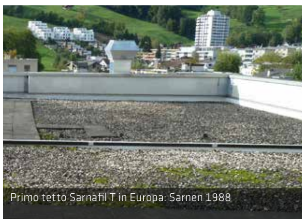
Il prelievo lo dimostra: struttura del tetto completamente asciutta anche dopo 25 anni.
