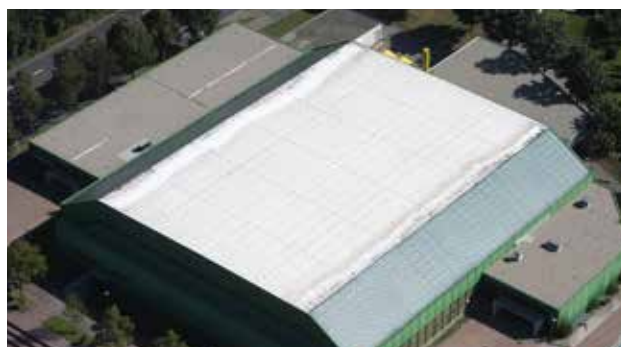
Stadthalle Sursee con Sarnafil TS 77
