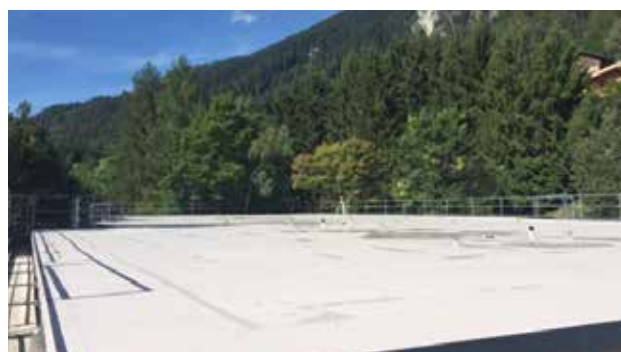
Hallenbad Fiesch con Sarnafil TG 76 FSA
