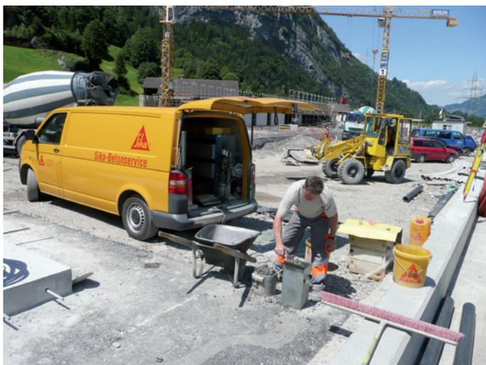
Gegen zu frühes Austrocknen des Betonbelags: Curing mit Antisol-20.
