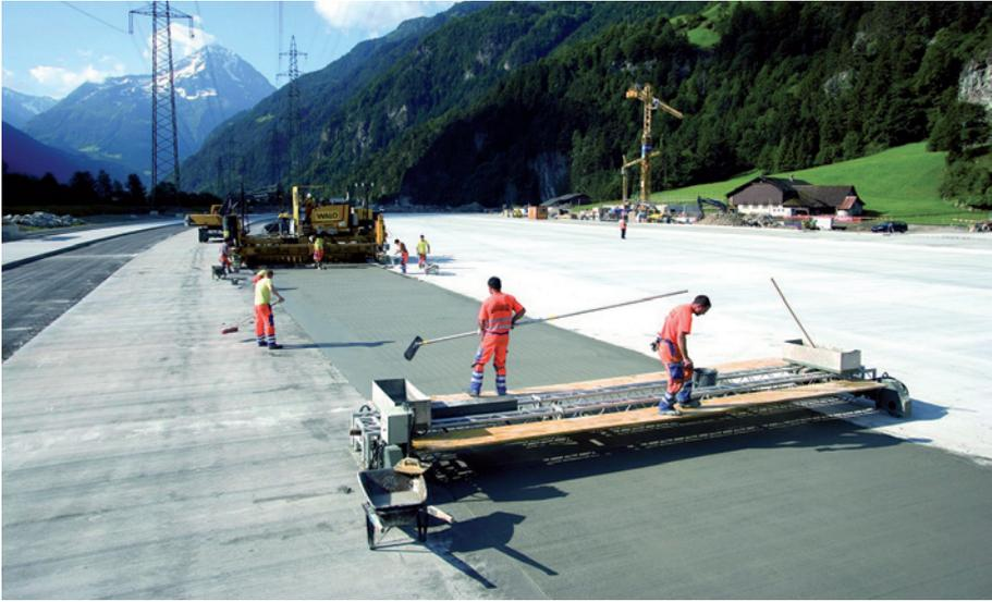
Mit einem Betonfertiger wurden rund 55 000 m<sup>2</sup> der Gesamtfläche in Tagesetappen bis zu 600 m Länge und 6 m Breite eingebaut. Der geoptisch gesteuerte Fertiger läuft auf den bereits erstellten Fahrbahnen. (Bild: Holcim Schweiz)
