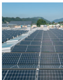
Sotto pannelli fotovoltaici
