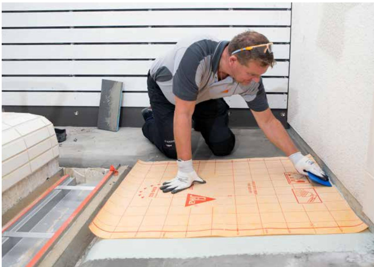
Collage de la SikaCeram® Sealing Membrane A avec SikaCeram® Sealing Fix.
