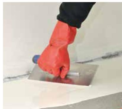
Appliquer le produit d'étanchéité en polyuréthane Schönox® EA PUR / EA PUR S avec une spatule dentelée e 6 mm.
