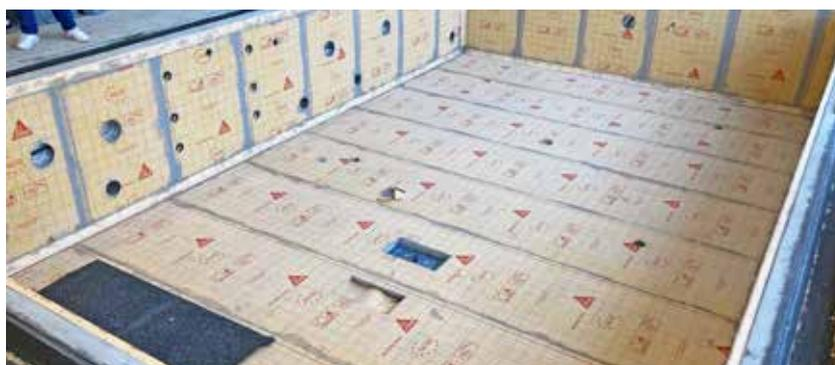
Utilisation de la SikaCeram® Sealing Membrane A sous l'eau.
