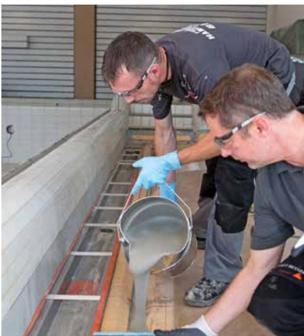
Coulage par étapes du joint anticapillaire à l'aide d'un gabarit fabriqué
