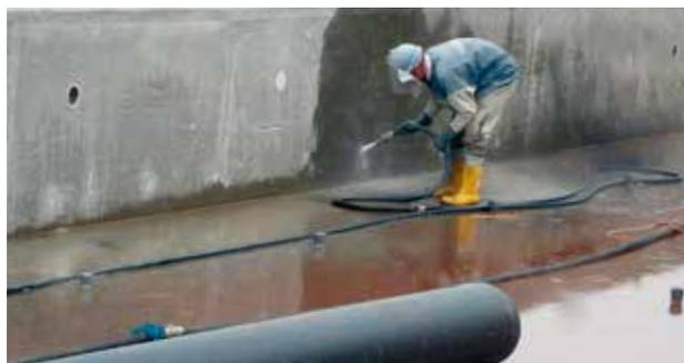
Un contrôle rigoureux de la qualité du support et de sa capacité portante est très important. Lors des préparations, du béton lisse de décoffrage est prétraité par un procédé mécanique tel que la technique de projection d'eau ou par jets d'air comprimé avec un agent de pulvérisation solide afin de créer une surface qui puisse être connectée. En cas de largeurs de fissure de  $\geq 0.1$  mm, il convient de s'entendre avec le planificateur sur d'éventuelles injections.
