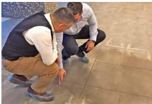
Dégâts dus à l'humidité en raison de l'absence d'une barrière capillaire.
