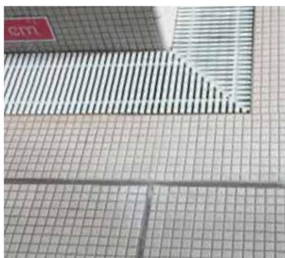
Les joints de dilatation doivent uniquement être remplis avec des matériaux de remplissage de joints appropriés et élastiques. Les joints de dilatation et les obturations de joint doivent être produits selon SIA 274.
