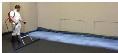
11. Lors de la pose et durant les 60 heures qui suivent, les locaux doivent être hermétiquement fermés afin de conserver l'humidité nécessaire pour une prise complète (ouvertures de portes et de fenêtres, cages d'escaliers et d'ascenseurs, grands conduits d'aération, dessous de portes, etc.)
