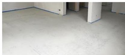
14. Le traitement avec **Sikafloor® ProSeal W** est obligatoire pour les chapes apparentes (directement sur la chape fluide ciment fraîchement posée).
