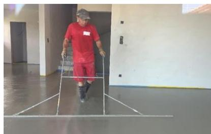
10. Lorsque les locaux ont une hauteur supérieure à 2.5 m, toute la surface doit être directement traitée avec **Sikafloor® ProSeal W** après le lissage, afin d'éviter la fissuration causée par une dessiccation trop rapide.
