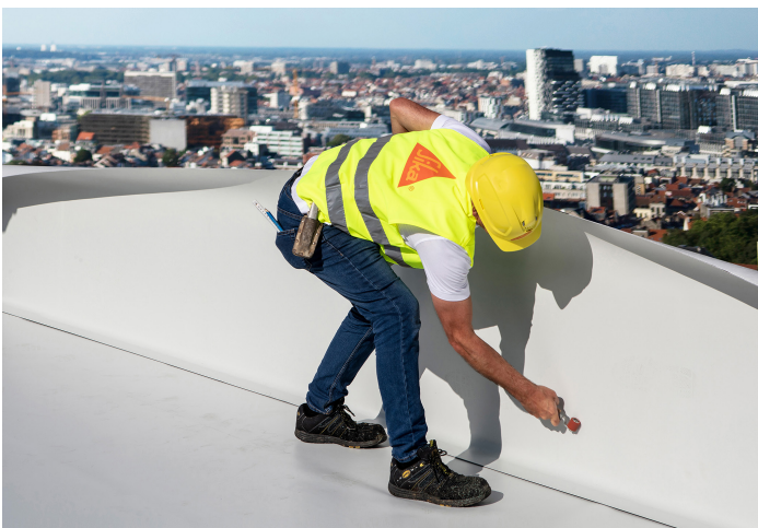
Revolutionäre Systemkomponenten wie die Selbstklebbahn SikaRoof AT FSA P für Aufbordungen ergänzen das Dachsystem der nächsten Generation!
