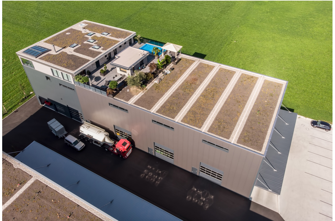
SikaRoof AT – EINE Bahn für alle Aufbauten (begrünt, bekiest, begehbar, nackt)
