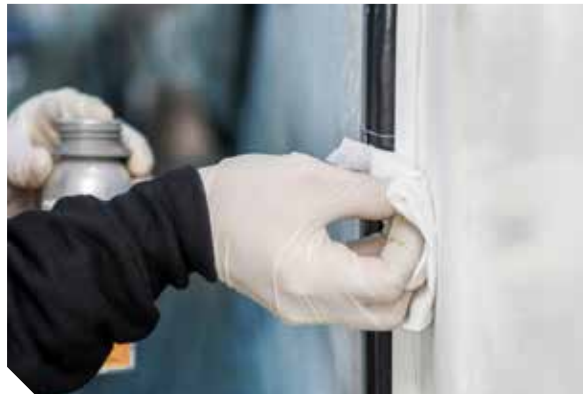
Vorbehandlung des Keramiksiebdruckrands mit Sika Aktivator-100
