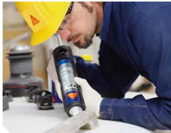
Verklebung der Scheuerleiste mit Sikaflex®-292i
