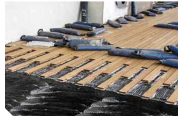
In Sikaflex®-298 eingebettete und mit Gewichten fixierte Teakleisten
