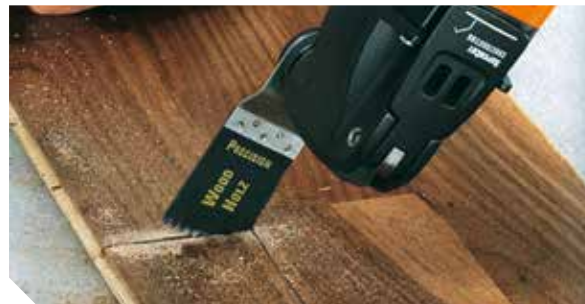
Trennen der Leisten mit einer Vibrationssäge
