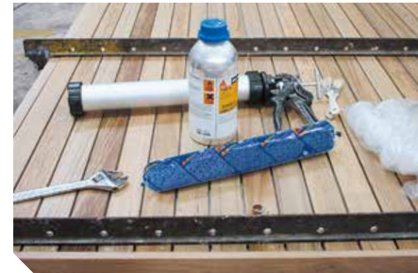
Stabdeck zur Aushärtung eingespannt
