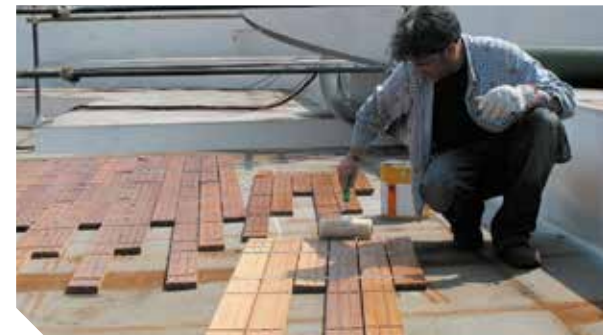
Auftrag von Sika® MultiPrimer Marine mit einer Walze auf ein Teakdeck (Rückseite)
