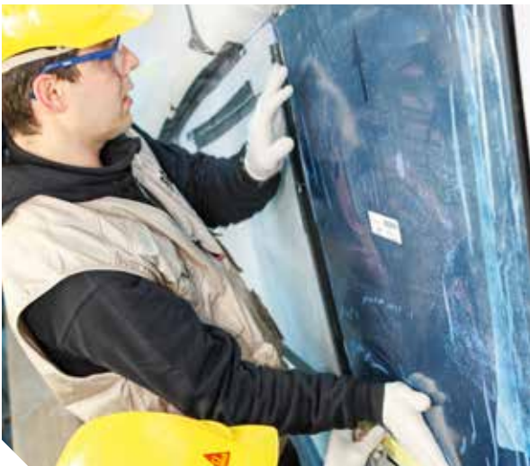
Die Scheibe kann direkt nach dem Fügen noch ausgerichtet werden
