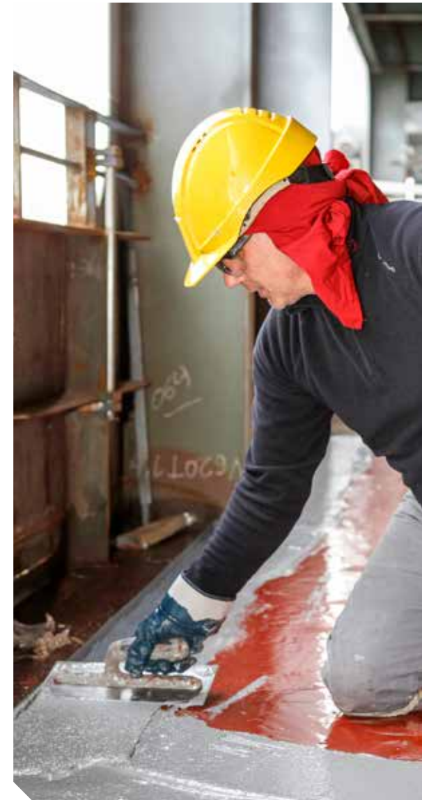
Verteilen von SikaTransfloor-352 SL mit einer Kelle
