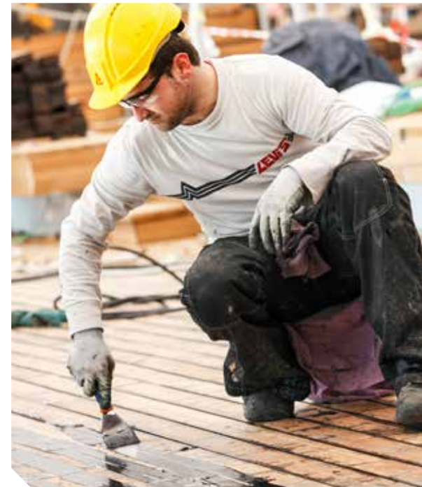
Sikaflex®-290 DC PRO mit einem Spachtel abziehen und einpressen
