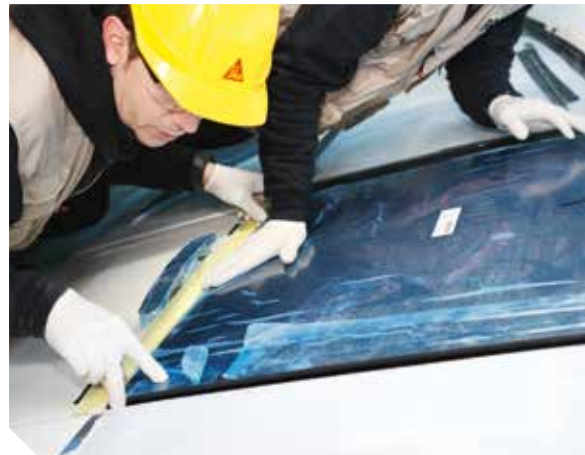
Auftrag von Sikaflex®-296
