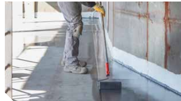
Auftrag von SikaCor® ZP Primer mit einer Walze auf ein Stahldeck
