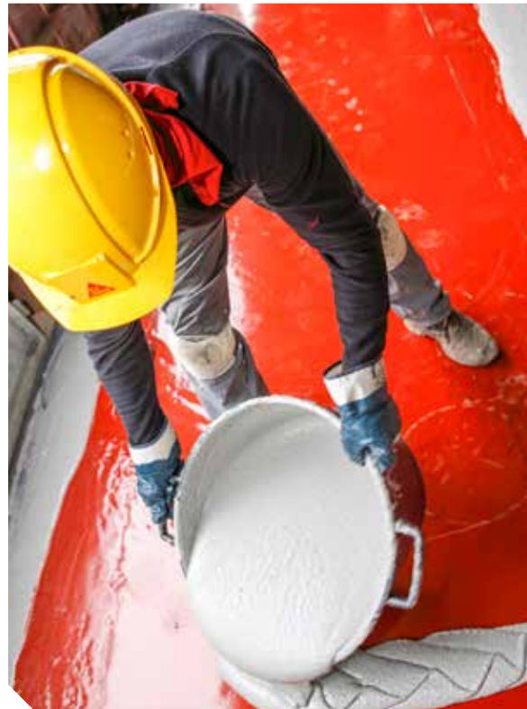
Ausgießen des fertig angerührten SikaTransfloor®-352 SL auf das Deck
