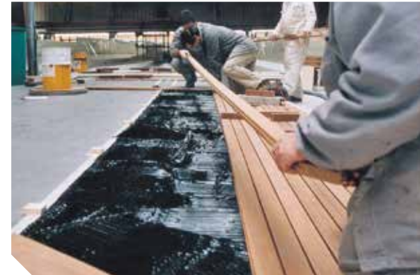
Aufbringen des Decks
