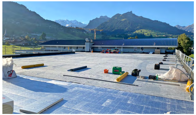
Zusätzliche Dämmung
