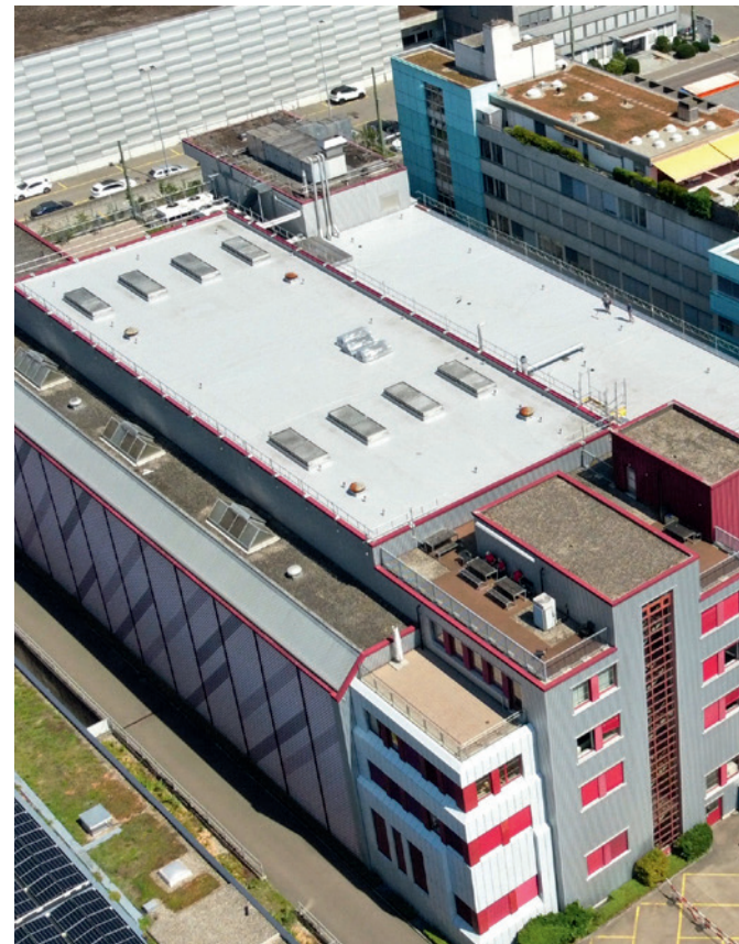
Für das grossflächige PAWI-Dach kam die Kunststoffabdichtungsbahn Sarnafil® TG 66-18 zum Einsatz...
