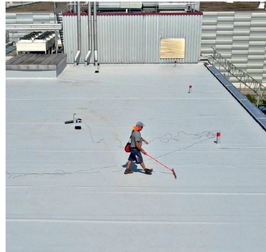
Die finale Abnahme auf Dichtheit und Beschädigungen kann mit SikaRoof® SmartControl präzise erfolgen – ohne Bewässern.
