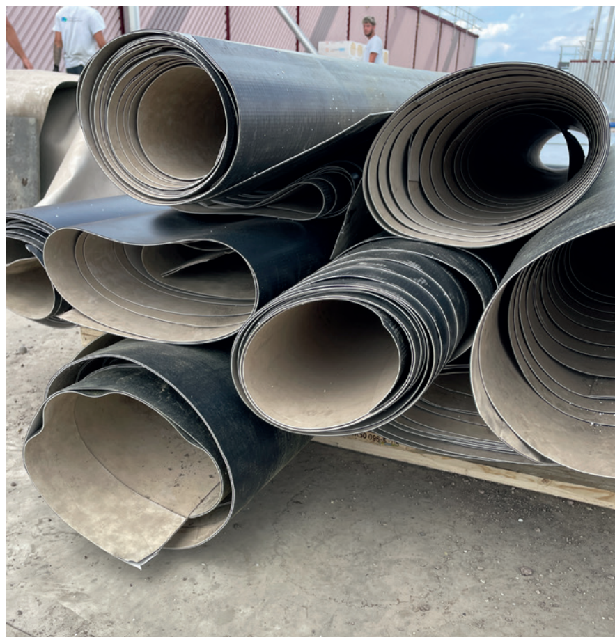
Die ausgebauten und aufgerollten Kunststoffbahnen wurden direkt auf der Baustelle von Sika übernommen und anschliessend vollständig recycelt.
