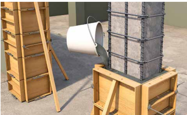
Réfection par coulage des sections de base des poteaux pour des éléments verticaux
