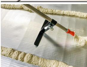
6. SikaRoof® Board Adhesive streifenweise auf den Untergrund auftragen. Dämmstoffplatten möglichst rasch in den Schaum eindrücken (offene Zeit: ca. 3-4 Minuten).
